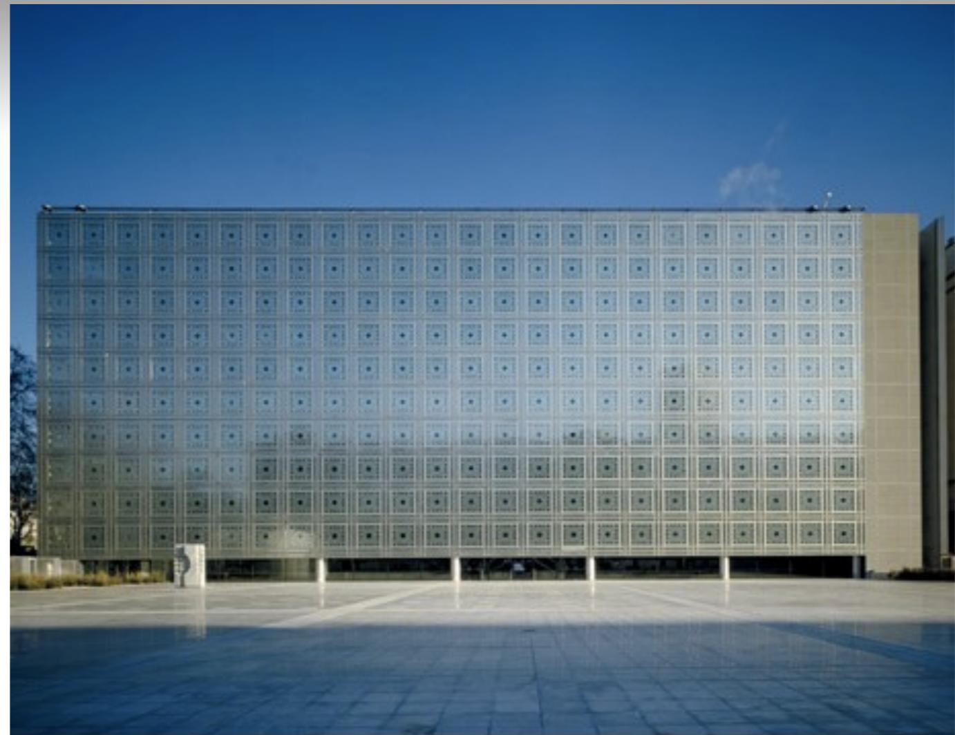
Das Institut du Monde Arabe, 1987, in Paris verfügt über verschiedene große Blenden an den quadratischen Fenstern. Sie steuern mittels Fotovoltaik den Lichteinfall und verändern so die Fassade des Gebäudes. Information bestimmt die Architektur : Information ARCHITECTURE
